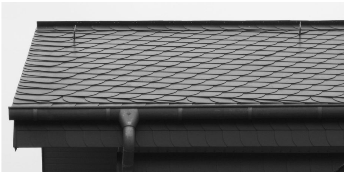
obr. 57, 58 – štítová hrana, hřeben, okap – krytí čtvercem s obloukem
