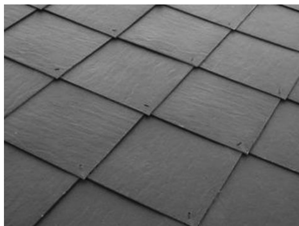
Obr. 10,11: Krytina ze čtvercových desek se dvěma zkosenými rohy se používá pro jednoduché krytí ve vodorovných řadách.
