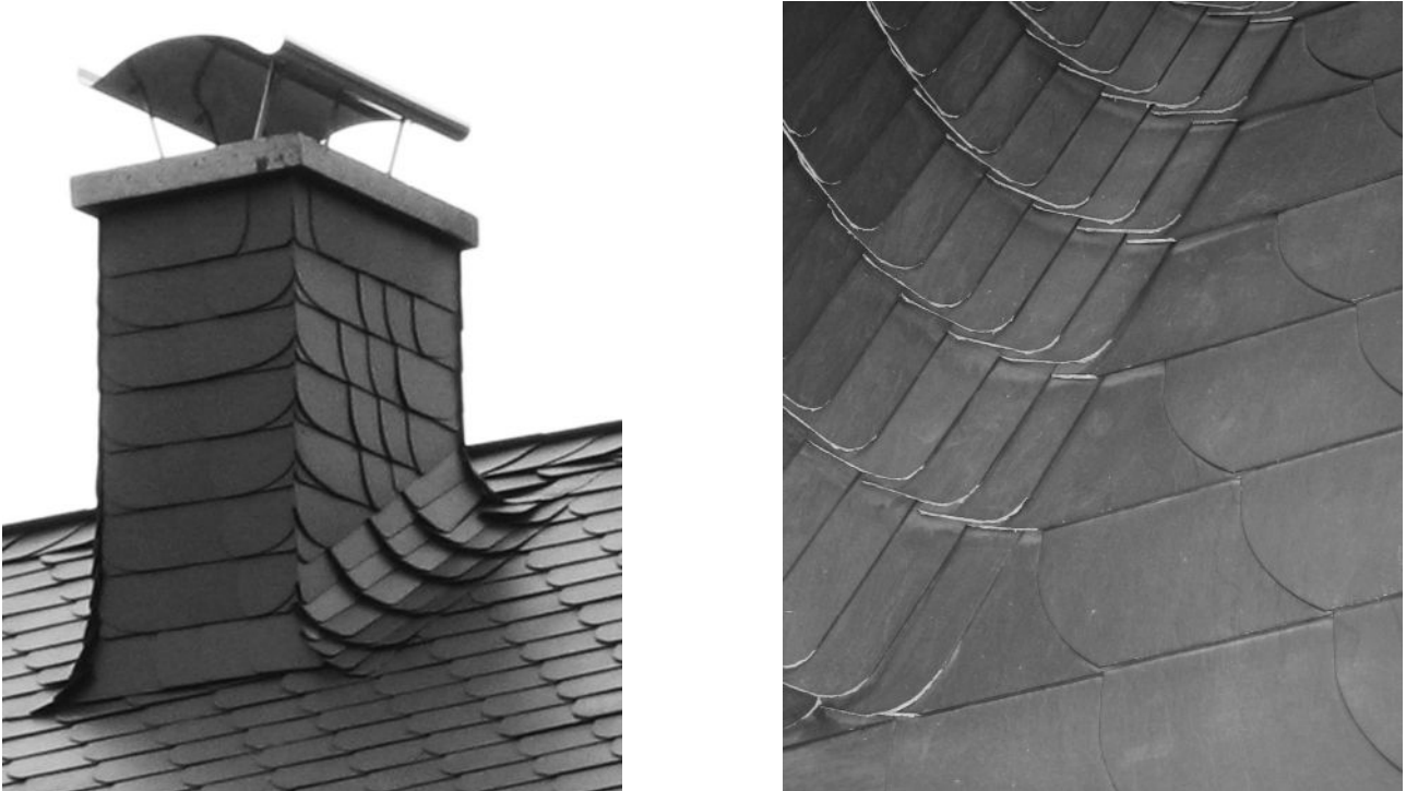
obr. 76, 77 – komín pokrytý vláknocementovými deskami
